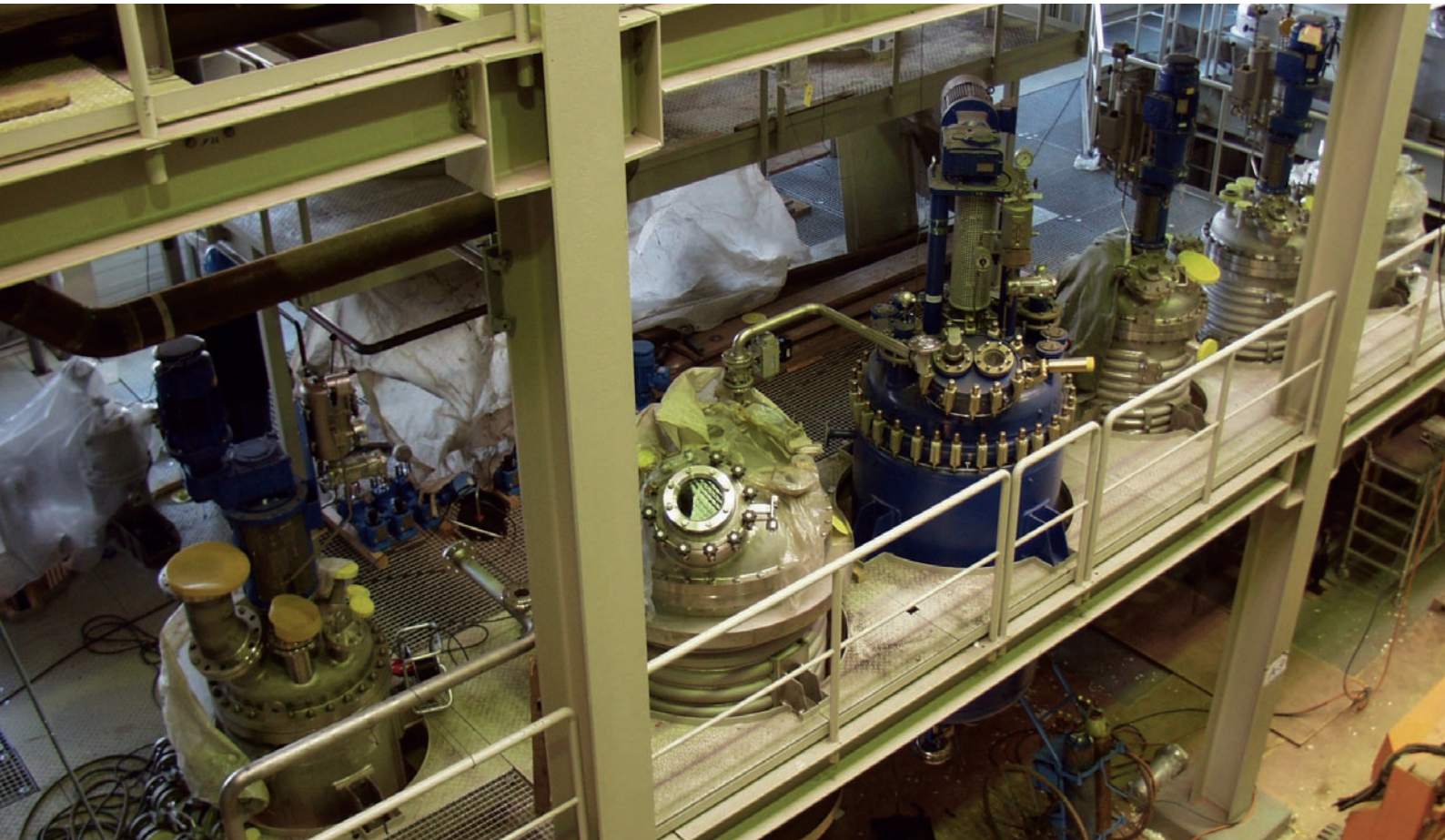
Einbau von Reaktoren im Synthesetechnikum im März 2005
